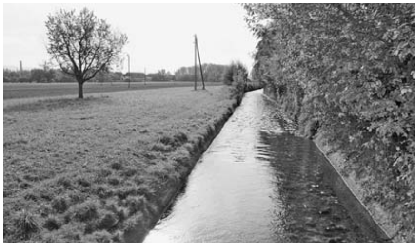
Die Uferpartien des Neuen Teichs sind in schlechtem Zustand, was aus Sicht des Grundwasserschutzes problematisch ist. Foto: Sibylle Meyrat
