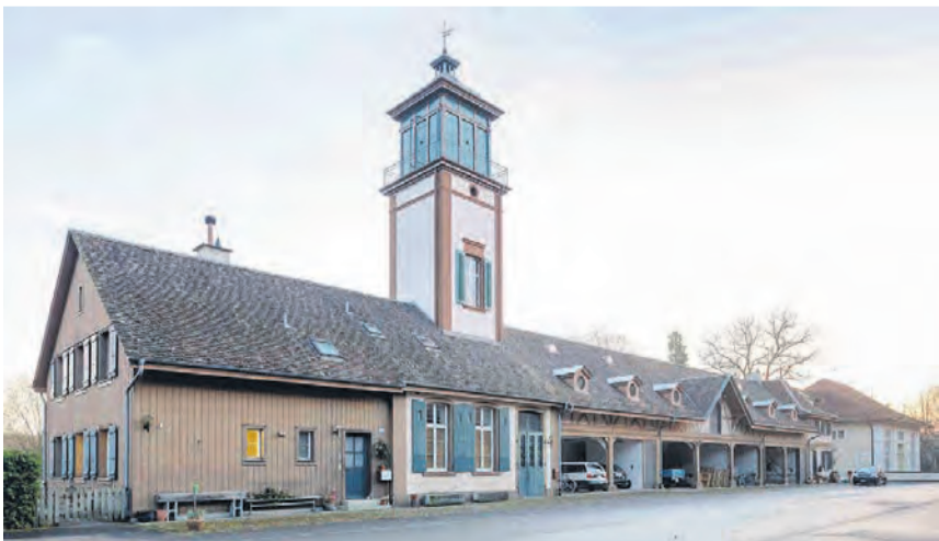
Das Bäumlihof-Pachtgut mit dem Badehaus kann am Open House besichtigt werden.
